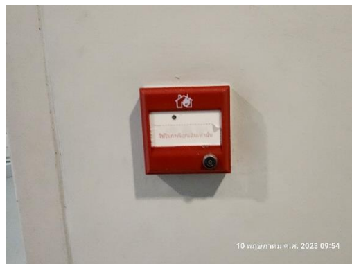
รูปที่ 26 ระบบป้องกันอัคคีภัยและเตือนภัย
