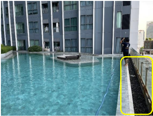
รูปที่ 13 รางระบายน้ำล้นมีฝาปิดรอบสระว่ายน้ำ
