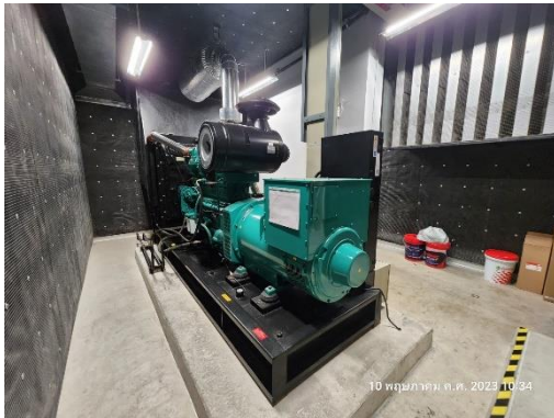
รูปที่ 24 ระบบไฟฟ้าฉุกเฉิน
