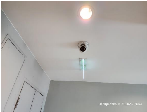
รูปที่ 35 ติดตั้งระบบ CCTV
